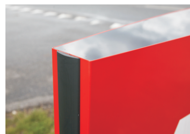
Base pyloner afsluttes med sort gummiliste.
